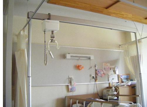
図2-3 居室にはXYレール以外に据え置き型が5台（アーチパートナー）
