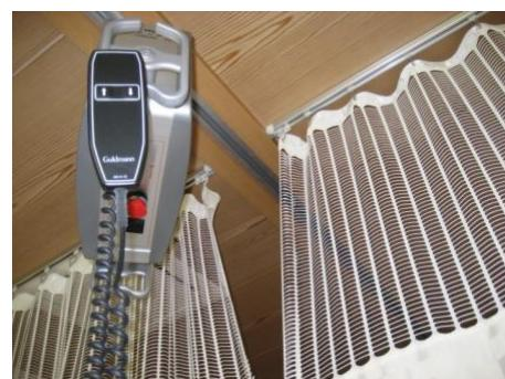
図1-2 レールがカーテンレールの間を通るように設計されている。
