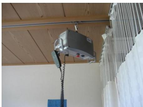
図1-1 4人部屋の天井走行レール式（グルドマン GH-1）レールが目立たないよう配慮されている。
