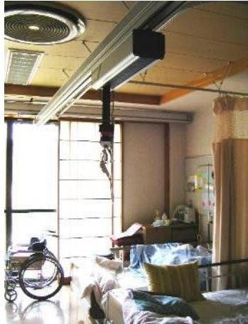
図2-1 従来型施設の4人部屋にXYレール式を配備すると、本体機器1つで4つのベッドをカバーできる。虹の里は6部屋に配備され24ベッドが使える（マスター・ライフ2300）
