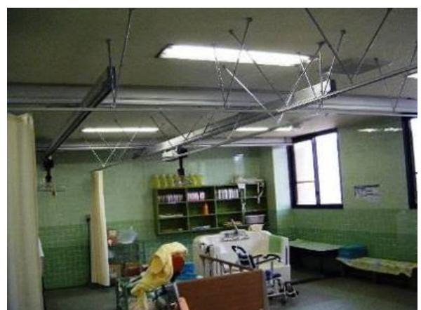
図2-4 大きい浴室にはXYレールが配備され、同時に2ヶ所で使えるようになっていく。カーテンレールより高い位置にレールが設置されているため、リフトの使える場所はカーテンレールの範囲内であるが、スペースは確保されている（マスター・ライフ2300）
